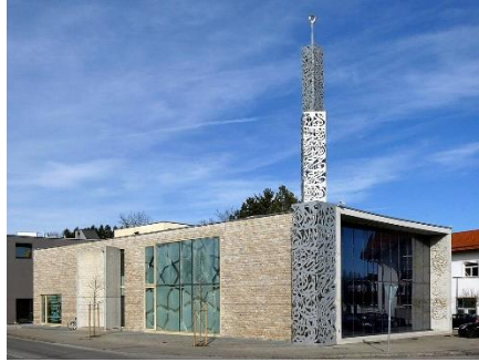
شكل 6: يظهر مسجد بينسبرج بألمانيا وتظهر فيه المئذنة مربعة المقطع.
